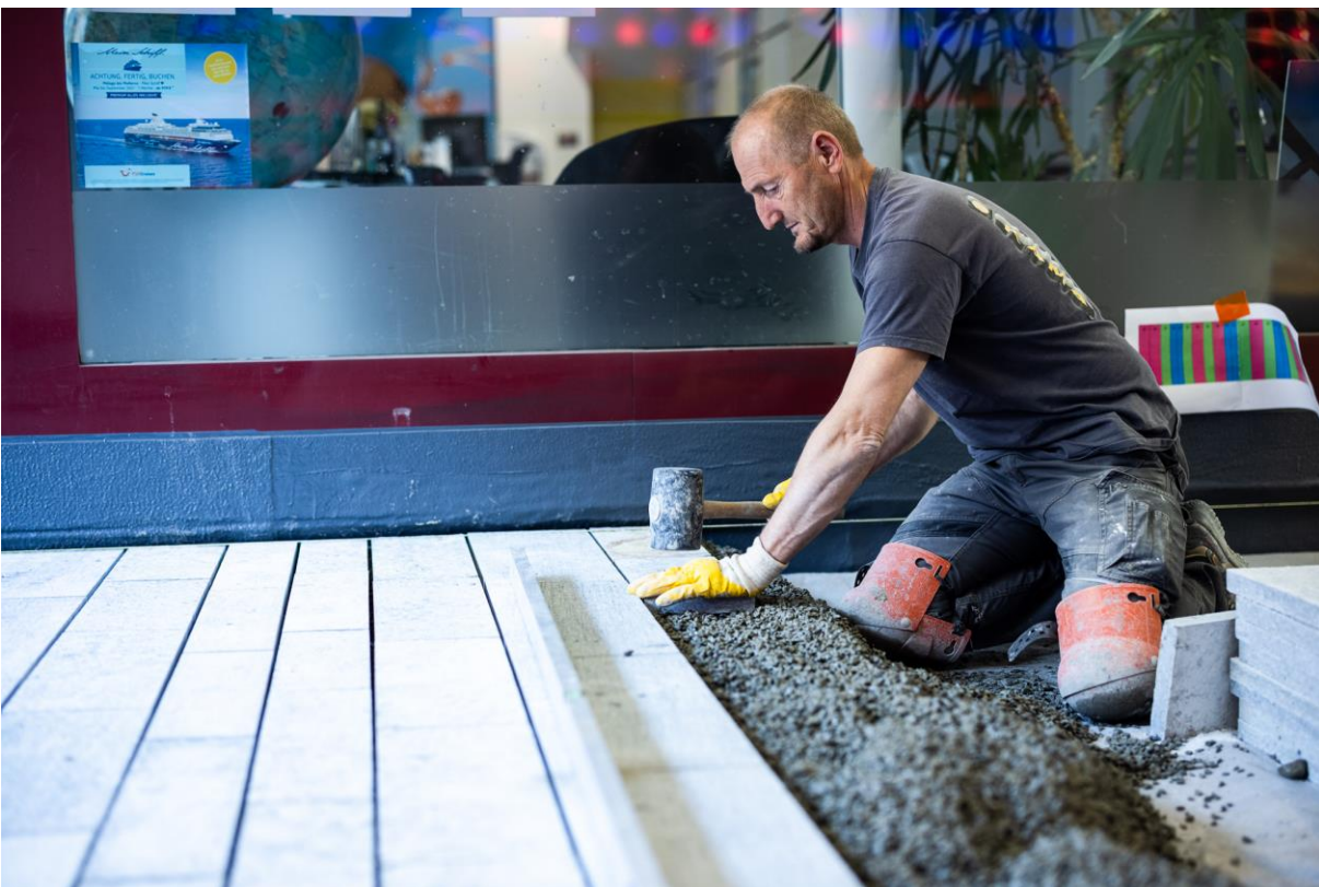
Verlegen des Natursteinbodens aus Gneis im Durchgang vom Sparkassenplatz zur Maria-Theresien-Straße Foto: Thomas Steinlechner, Abdruck honorarfrei.
