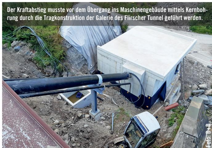
Der Kraftabstieg musste vor dem Übergang ins Maschinengehäude mittels Kernbohrung durch die Tragkonstruktion der Galerie des Flirscher Tunnel geführt werden.
