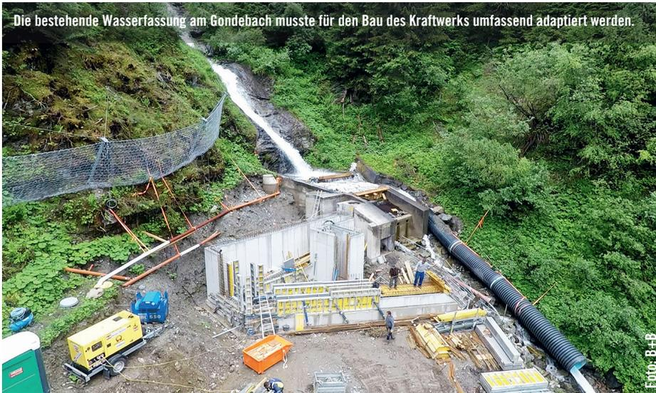
Die bestehende Wasserfassung am Gondobach musste für den Bau des Kraftwerks umfassend adaptiert werden.
