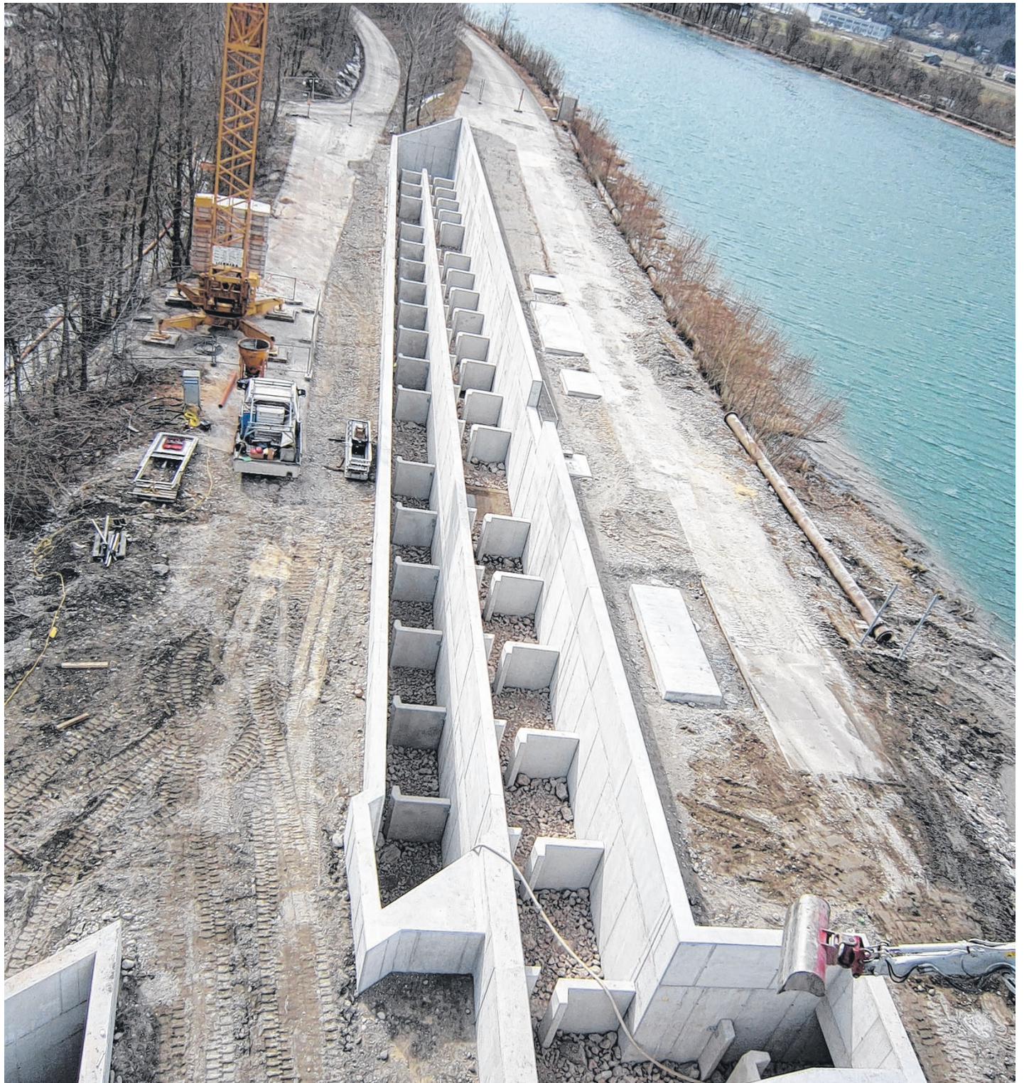
Die Fischwanderhilfe Hirnbach stellt am Kraftwerk Langkampfen die Fisch-Durchgängigkeit wieder her. Bis Herbst 2015 wird die volle Funktionstüchtigkeit erreicht.
