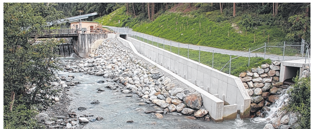
Fischstufe an der Pitze: Kleine Wasserbecken ermöglichen Fischen, den Höhenunterschied zwischen Ober- und Unterwasser zu überwinden.
