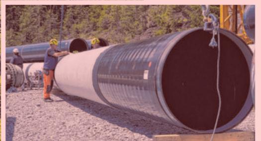
Die neuen Rohre werden im Tal vorbereitet und via Kran in Stellung gebracht.
